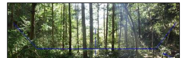
砂防堰堤計画箇所（上流⇒下流を望む）
